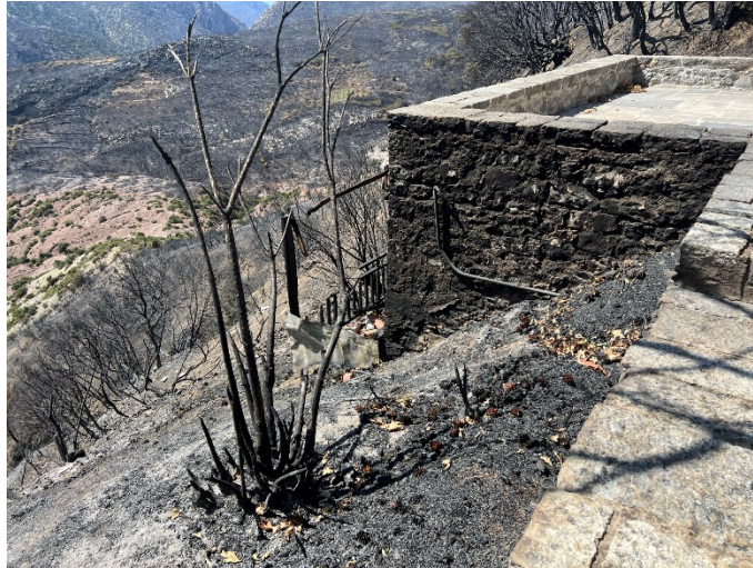
Εικόνα 5: Υφιστάμενη κατάσταση φέρουσας τοιχοποιίας
