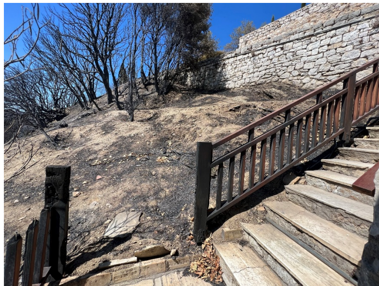
Εικόνα 4: Υφιστάμενη κατάσταση κλιμακοστασίου
